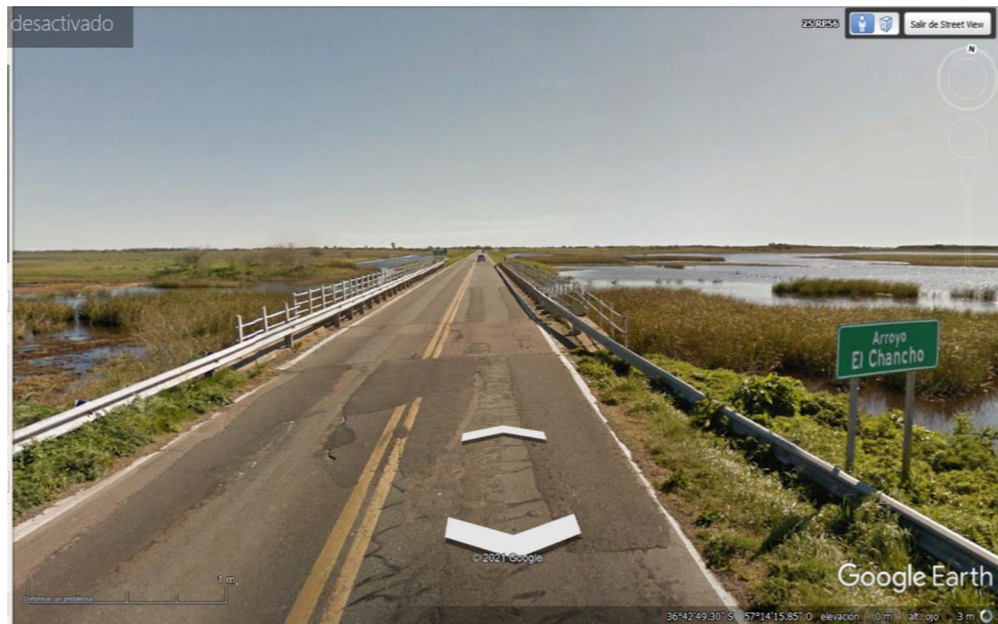
Imagen 3: Puente sobre Arroyo El Chancho en calzada existente-
